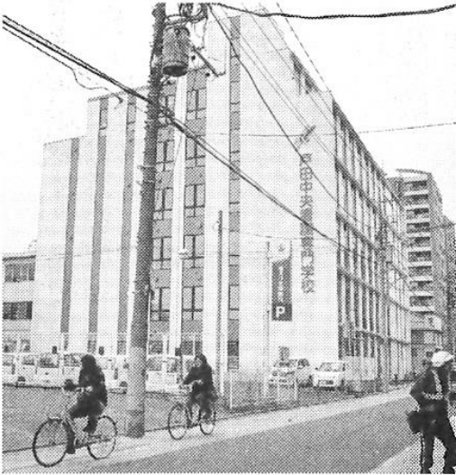
完成した戸田中央看護専門学校の新校舎—戸田市
